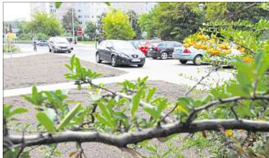
Statt geplanter drei Monate dauerte der Sammlerbau am südlichen Ring Richtung Hirschgarten die dreifache Zeit. Jetzt sind die Sperrungen und Umleitungen Geschichte. Die Fläche ist für Fußgänger, Radler und Pkw wieder nutzbar. Foto: Susann Fromm
